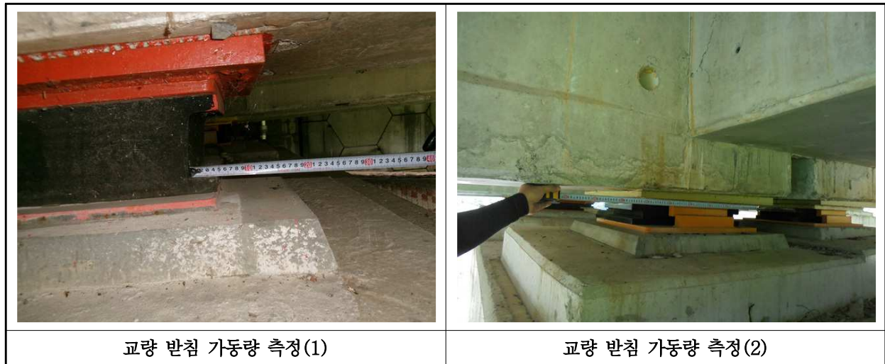
【사진 22.3.15】 교량받침 이동량 측정
