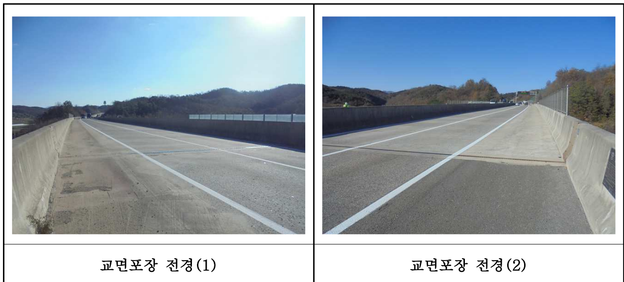
【사진 22.3.19】 교면포장 전경
