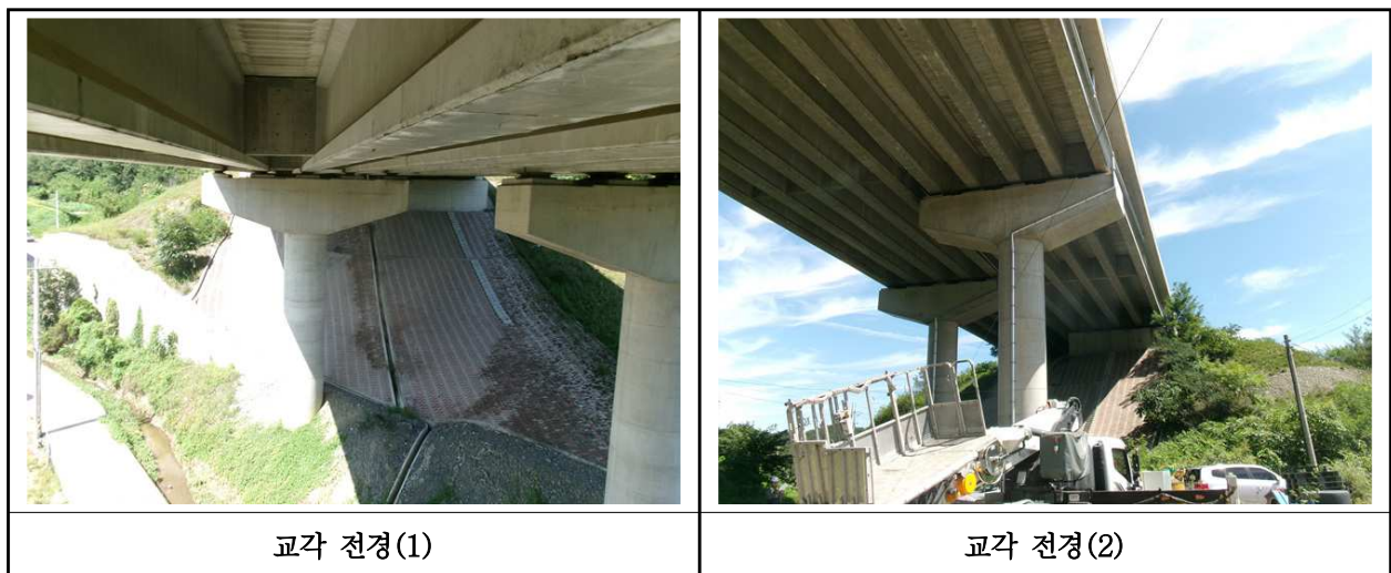
【사진 22.3.35】 교각 전경
