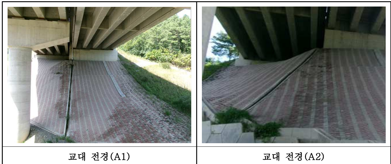
【사진 22.3.8】 교대 전경
