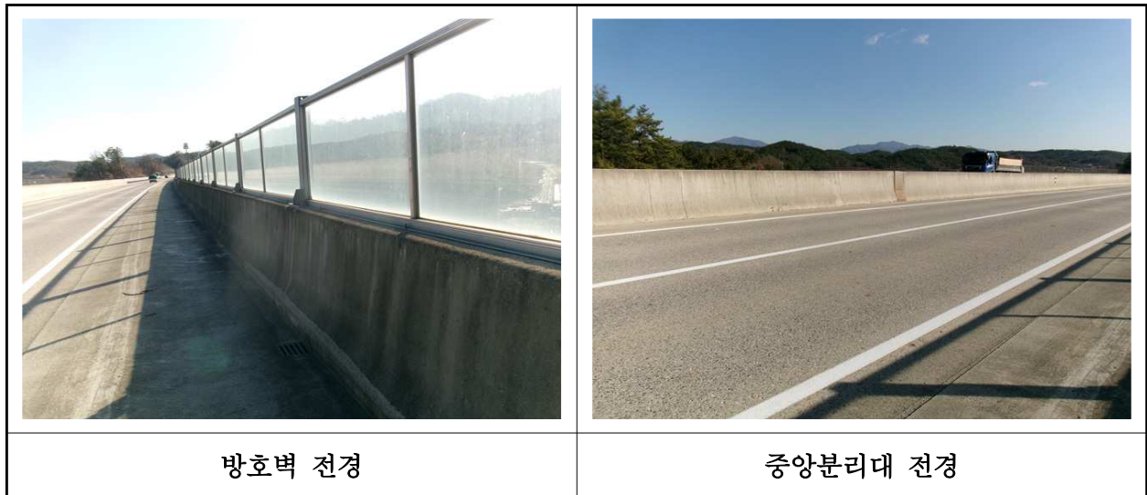
【사진 22.3.48】 방호벽 및 중앙분리대 전경
