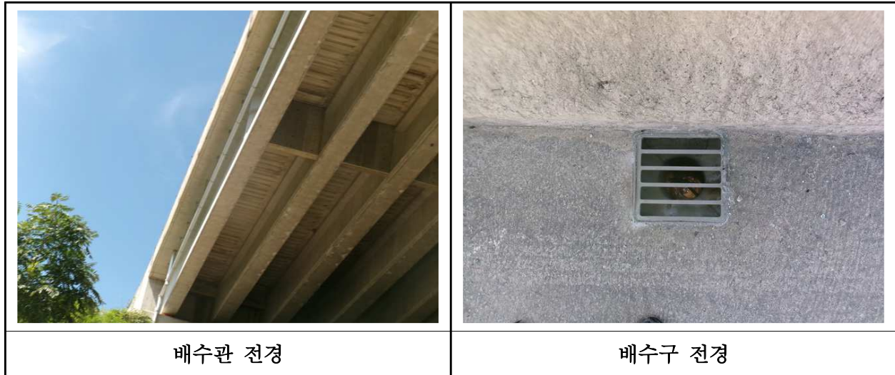
【사진 22.3.46】 배수시설 전경
