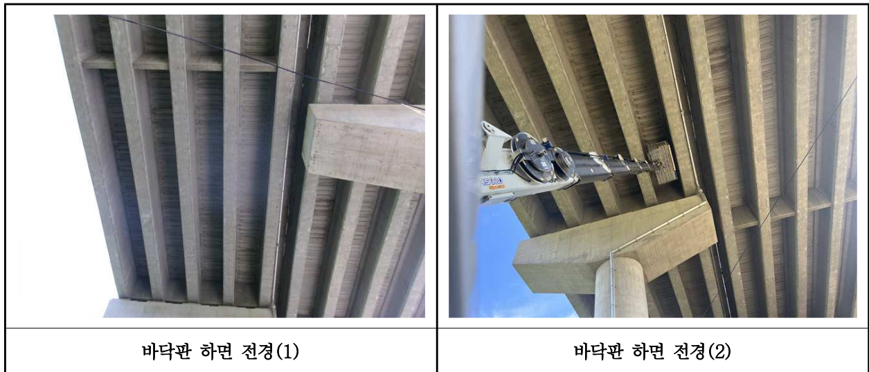
【사진 22.3.2】 바닥판하면 전경
