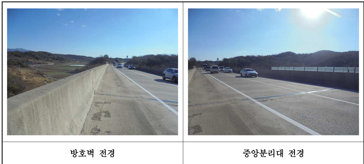
【사진 22.3.23】 방호벽 및 중앙분리대 전경
