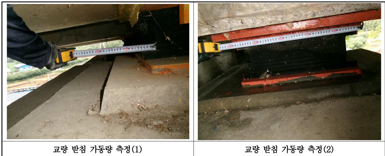
【사진 22.3.40】 교량반침 이동량 측정
