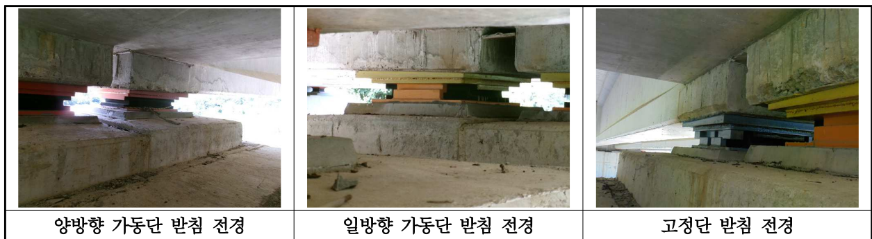
【사진 22.3.37】 교량받침 전경
