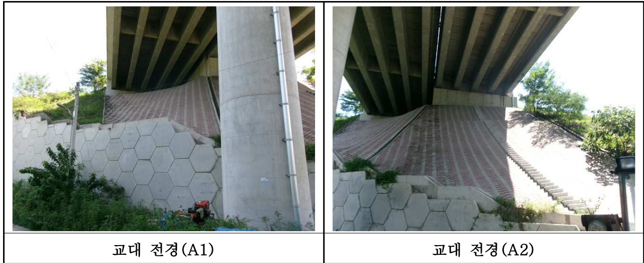
【사진 22.3.33】 교대 전경
