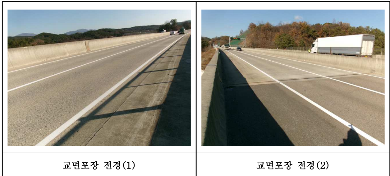
【사진 22.3.44】 교면포장 전경
